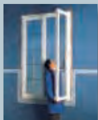
Pose des nouveaux ouvrants
